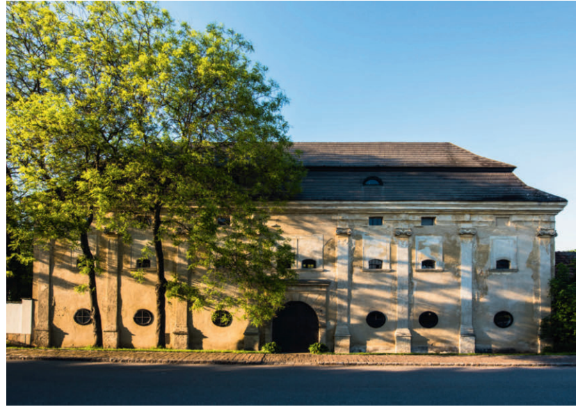
Abb. 7: Gattendorf, Altes Schloss, Fassade nach Restaurierung 2000/01
